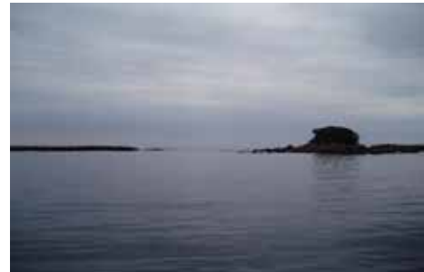
写真 竹ヶ島と二子島間の水路を湾内より望む防波堤
